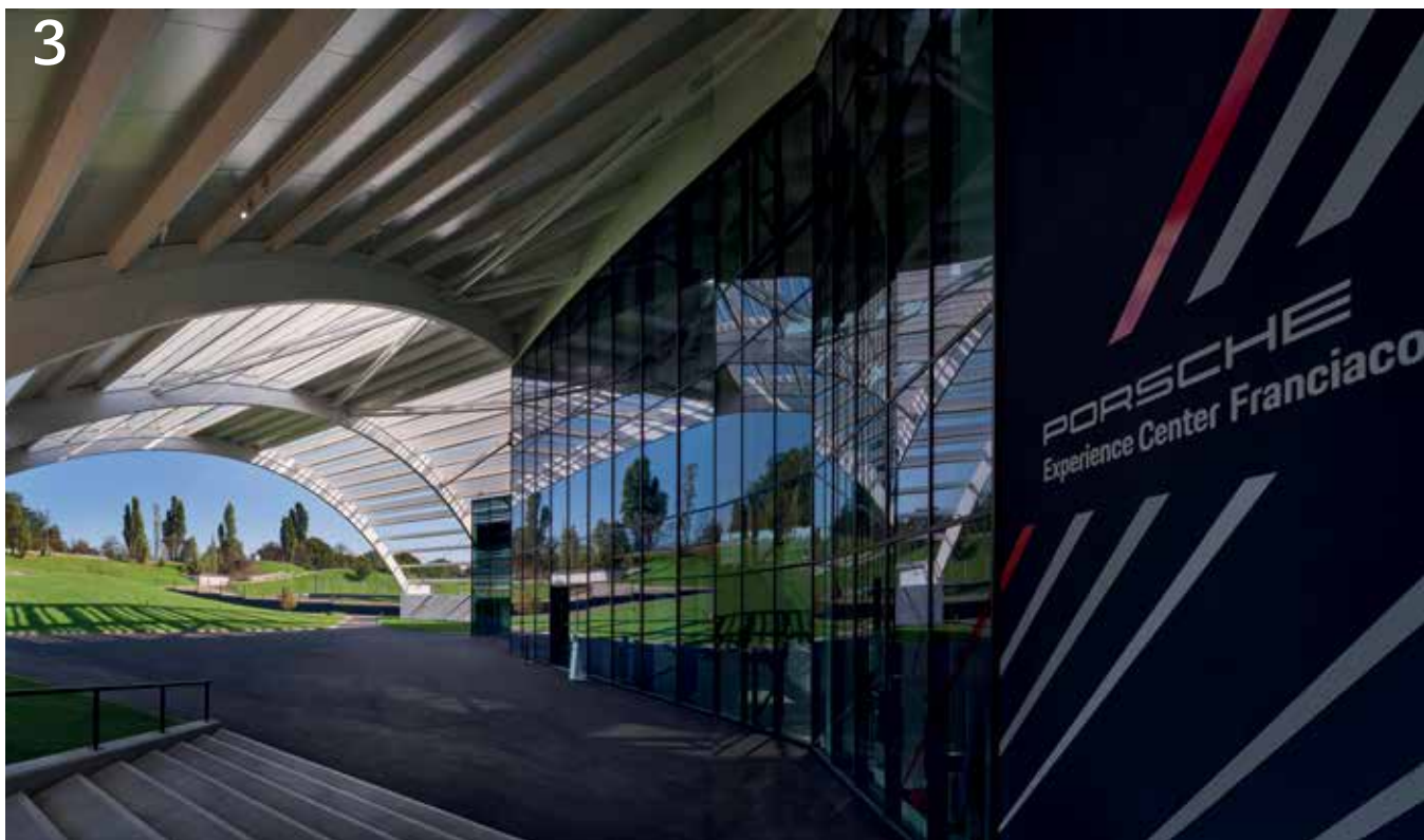
Figura 3 Il Customer Center è costituito da 11 arcate con un passo di 9 metri, un'altezza massima di 16 e una luce di 55
